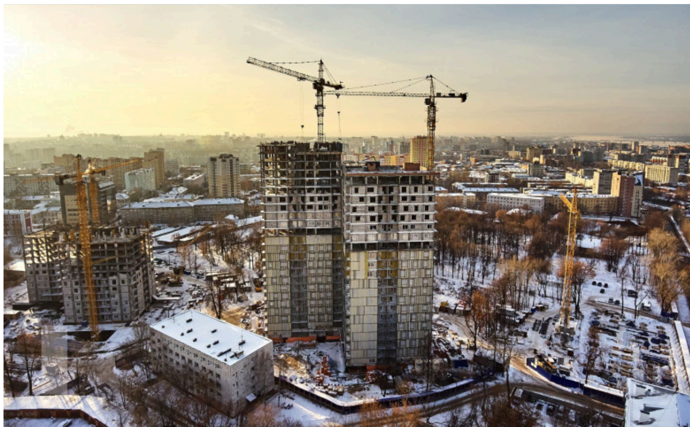
Строительство нашего дома в процессе — ноябрь 2016 года
